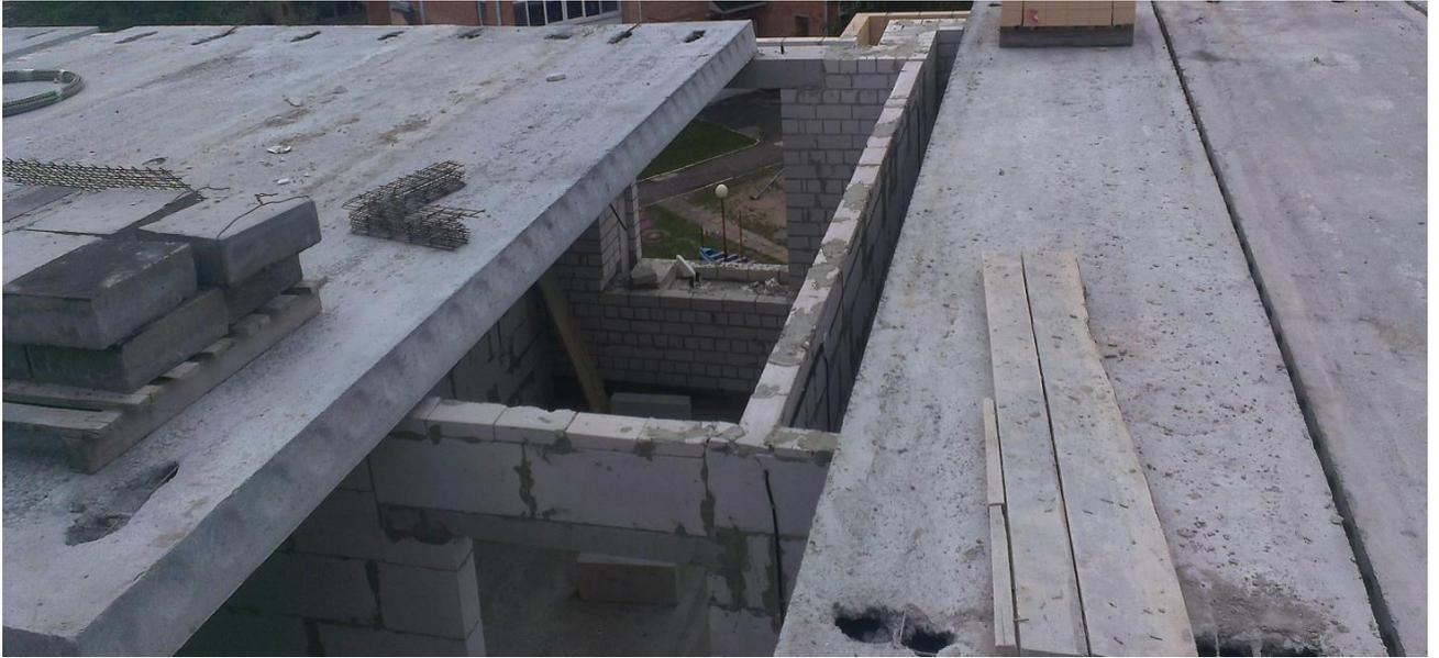
Плиты перекрытия смонтированы без предварительно выложенного из кирпича бортика на два ряда выше уровня укладываемых плит. Не выполнено ограждение перепада по высоте.
