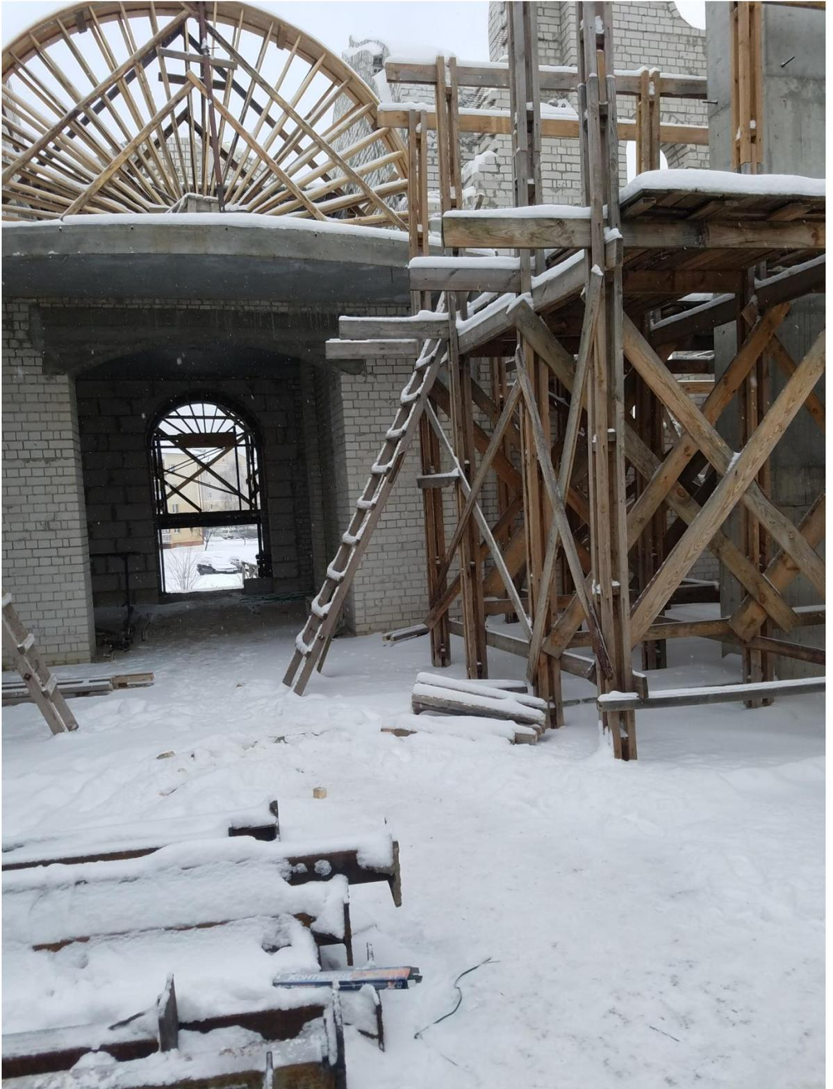
Подъем на леса по деревянной лестнице сбитой гвоздями. Отсутствует ограждение перепадов по высоте.
